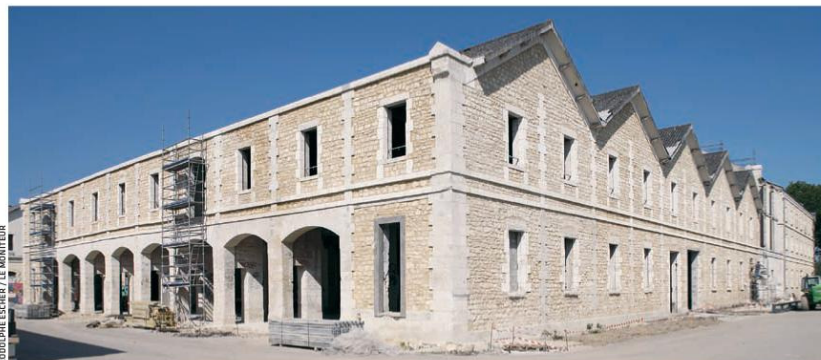
Les premiers bâtiments de la caserne Niel rénovés dans le cadre du projet Darwin. Ils accueilleront des activités tertiaires.
